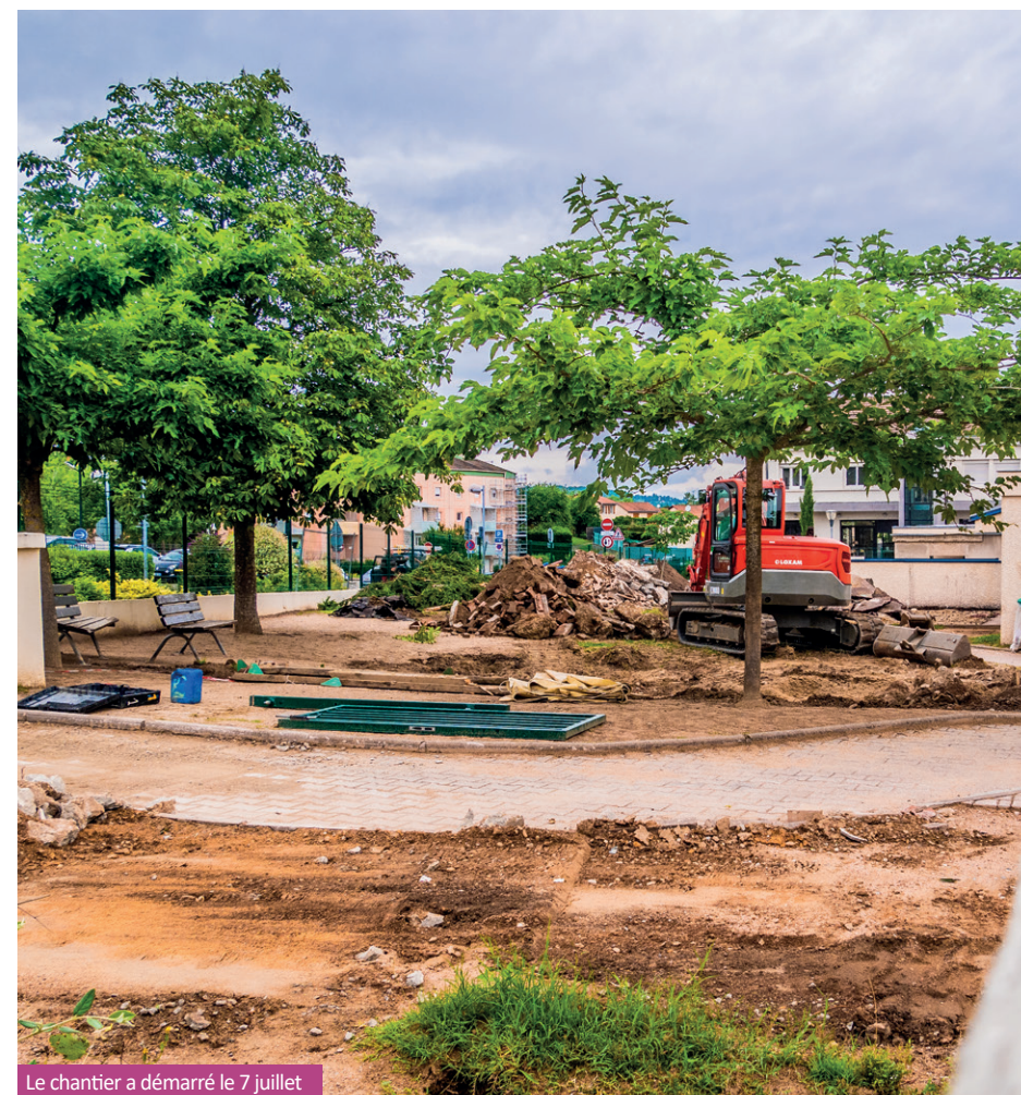
Le chantier a démarré le 7 juillet
